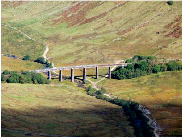
Fig 3. Auch Glenn Viaduct/West Highland Line. Photo Brian Davey
